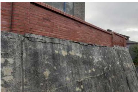
Suite à des infiltrations d'eau et au gel, le soubassement du mur situé autour du parvis de l'église s'est fissuré. Les travaux de réparation ont été chiffrés à 4000 € environ.
